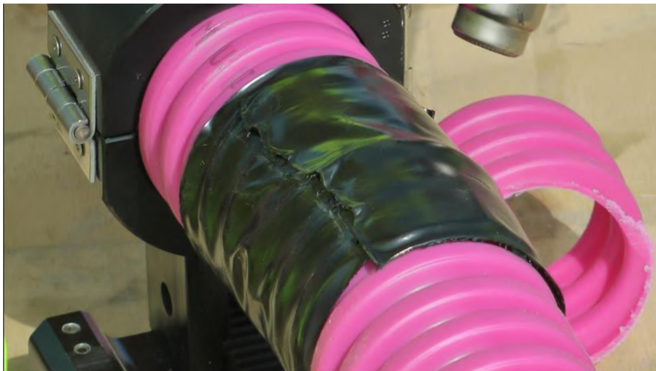
Нанесение термоусадочной ленты
