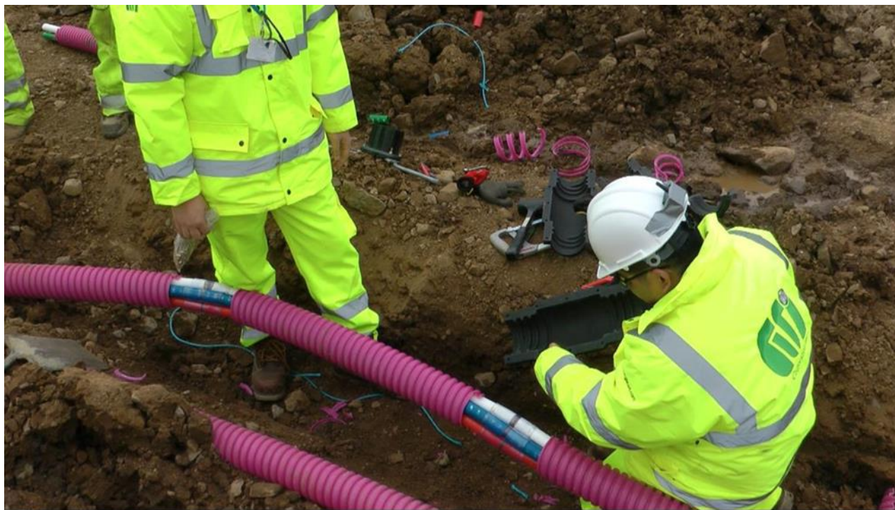
Полный ремонт канала ВК, показывают внутренние трубы и втулки, дающие герметичное уплотнение. Внешняя защита оболочки для стыков еще не установлена на данный момент.
