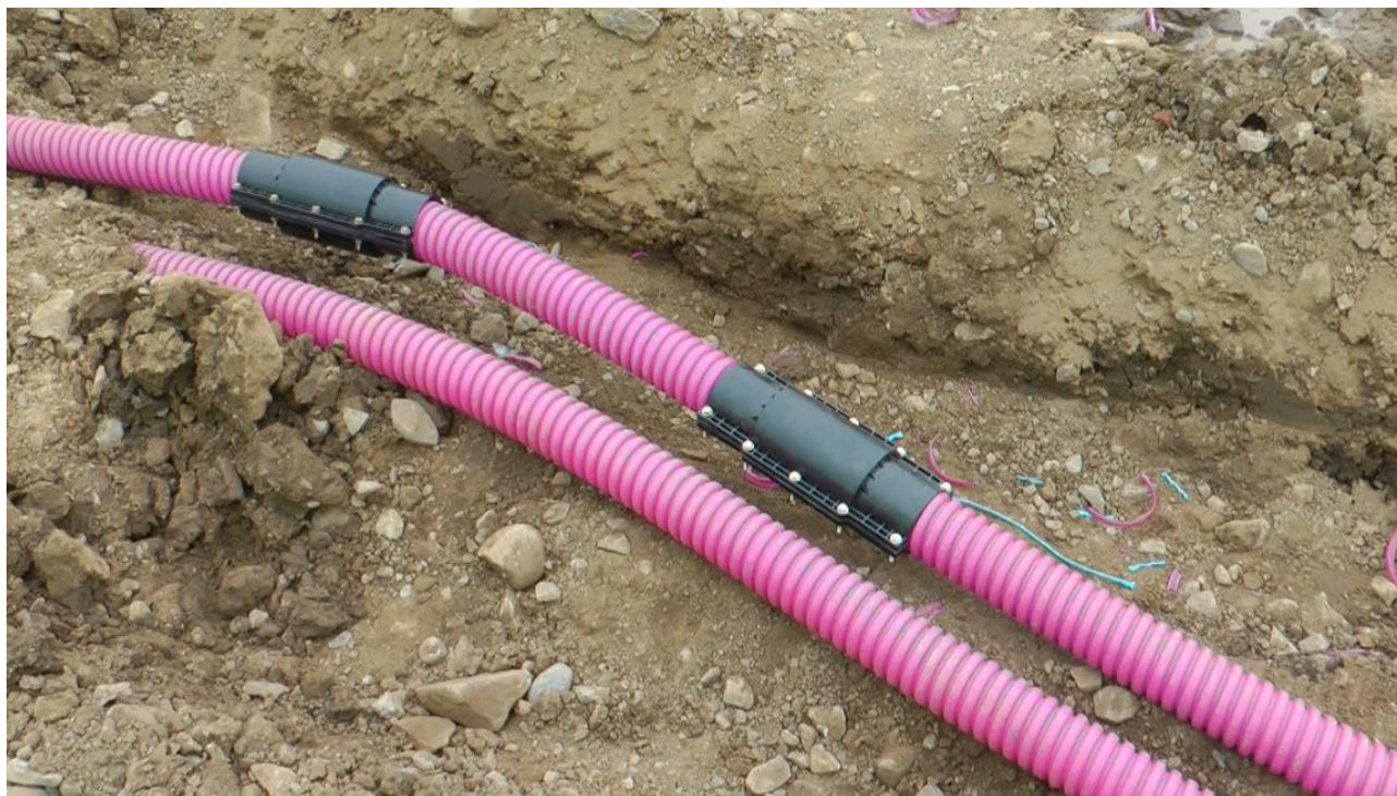
Отремонтированный ВК канал
