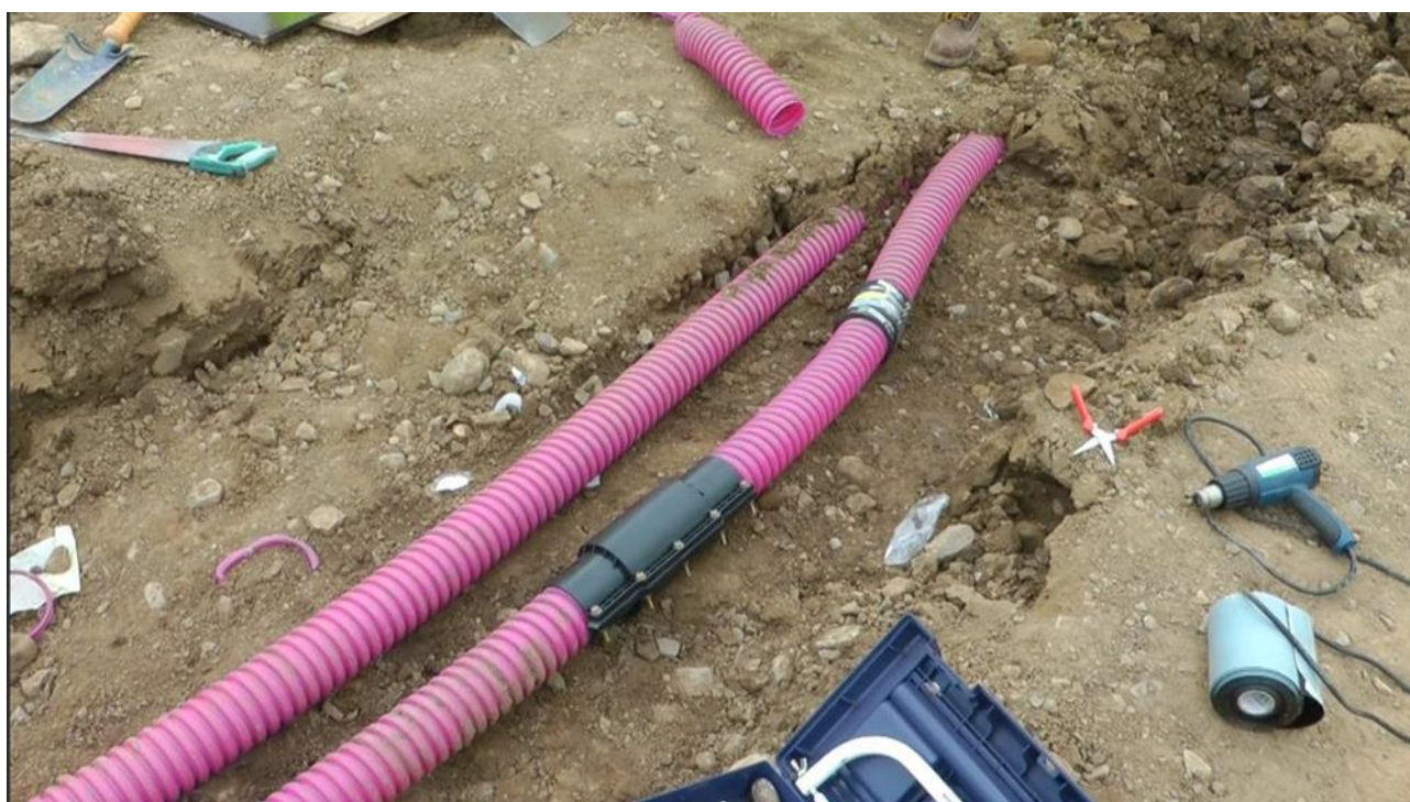
Отремонтированная труба
