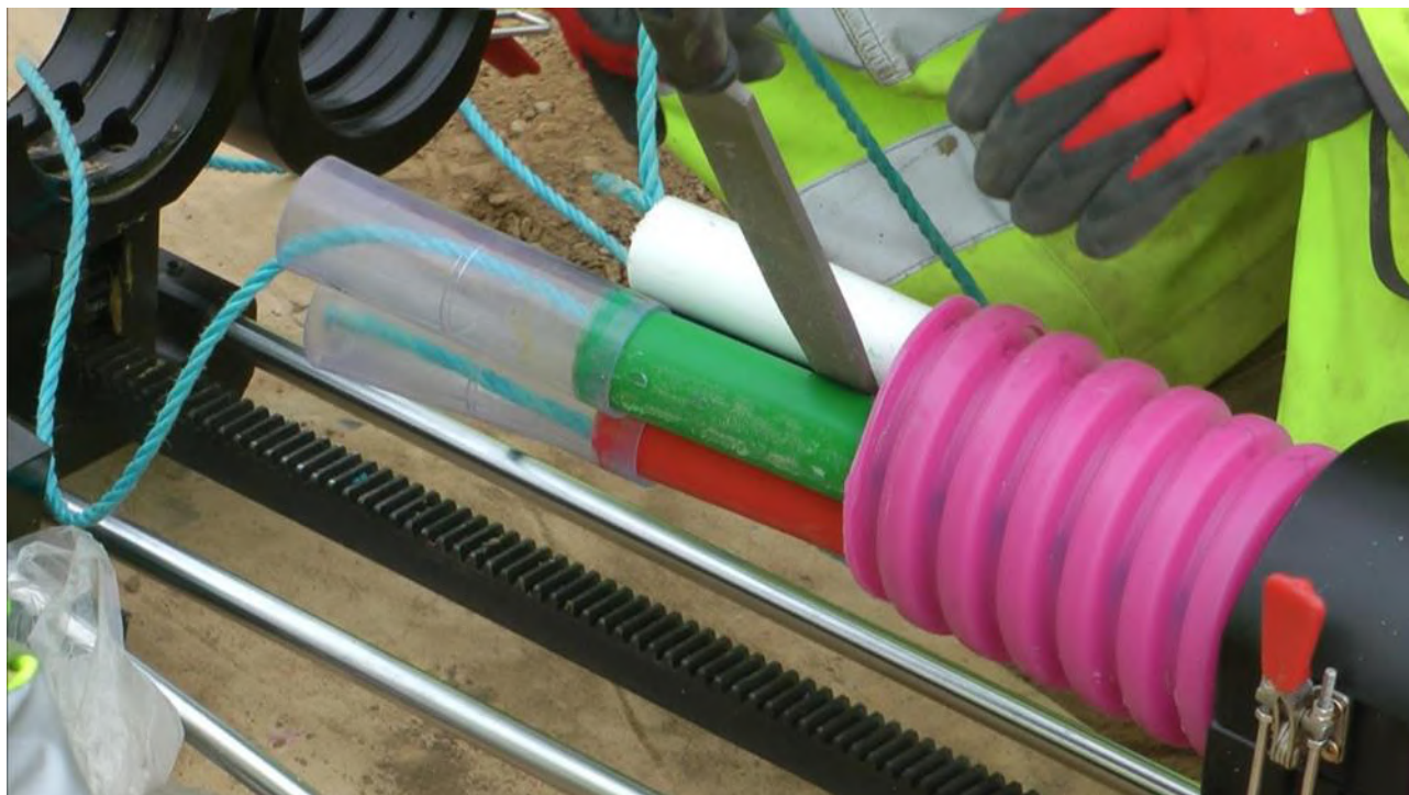
Промежуточное соединение ВК каналов
