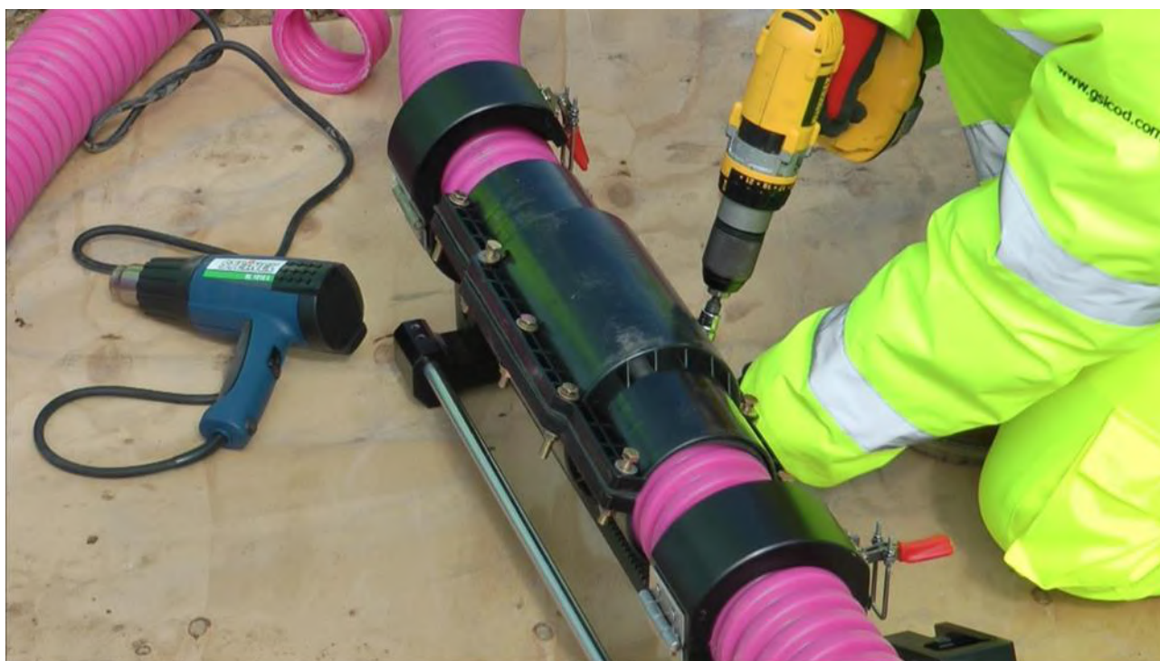
Установлена наружная защита оболочки.
